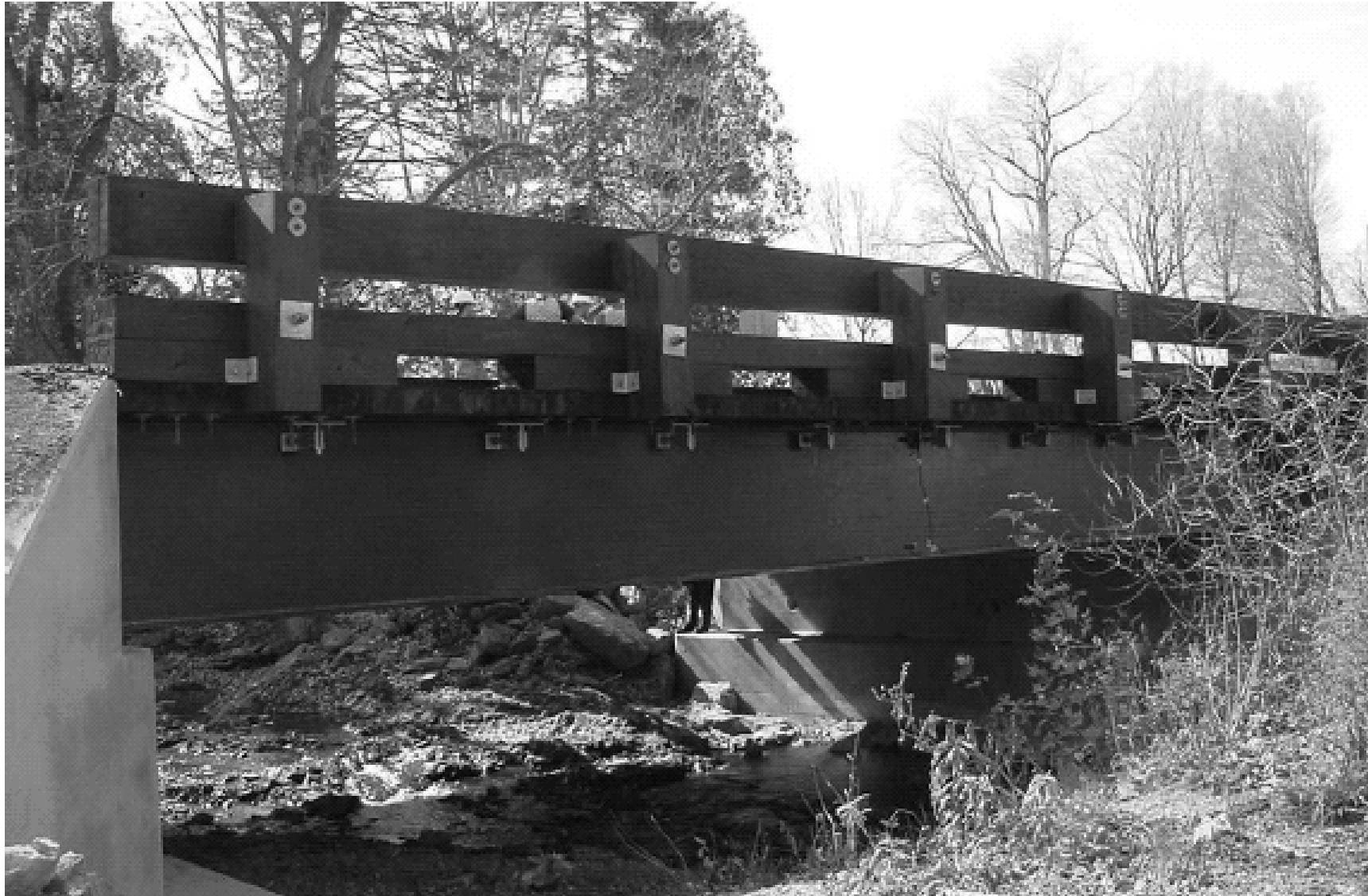
Ponte sul torrente Dickey in Smyth County, Virginia (USA)
